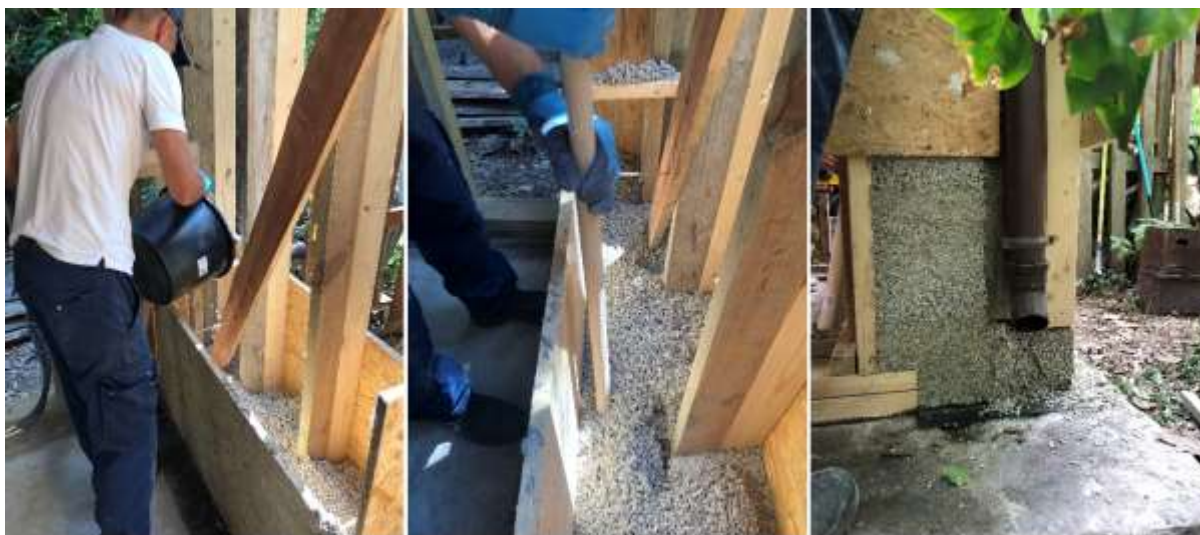
Rysunek 13. Proces wznoszenia ściany z kompozytu wapienno-konopnego metodą szalunkową (zdjęcie autora).
