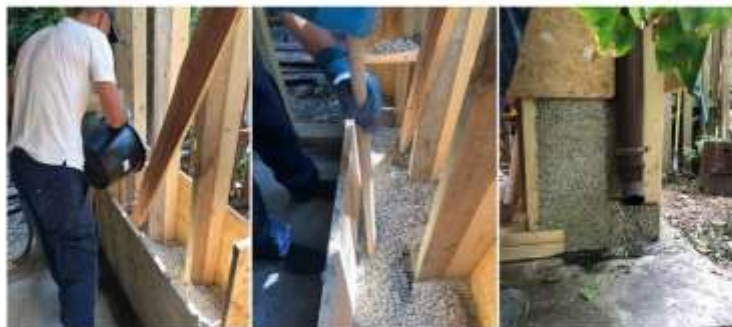
Rys. 1. Proces wznoszenia ściany z kompozytu wapienno-konopnego metodą szalunkową (archiwum autora)
