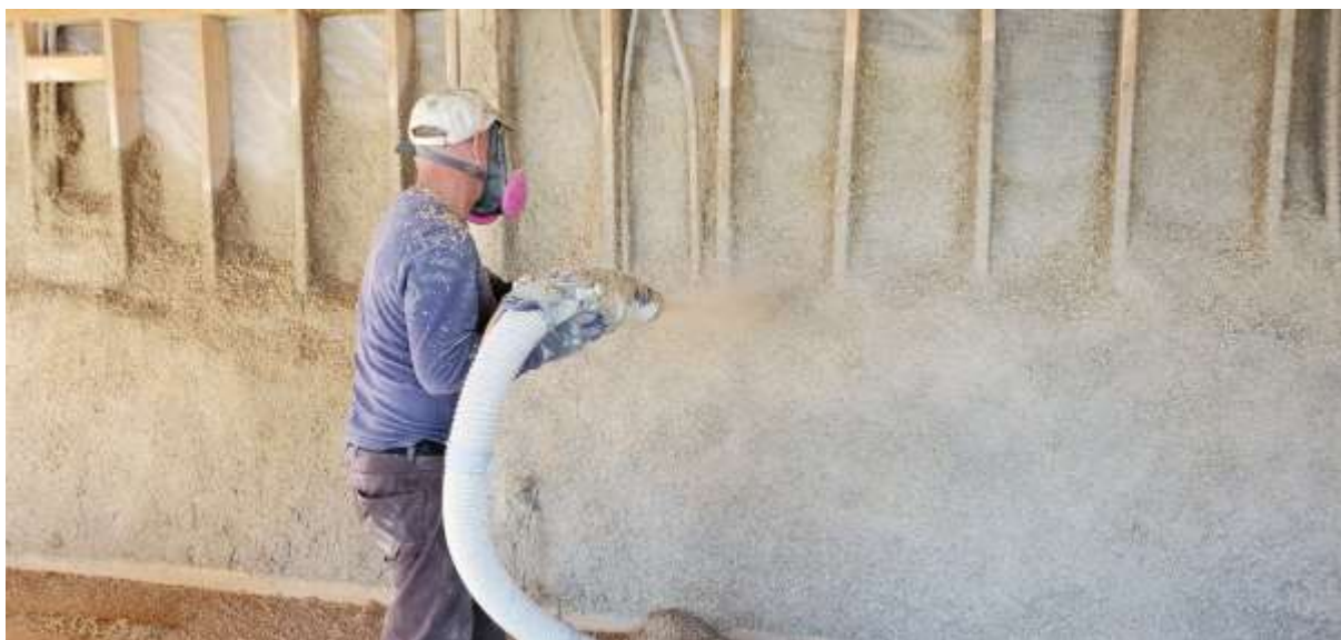
Rysunek 14. Natryskiwanie kompozytu wapienno-konopnego (źródło: https://hempstone.net/ )
